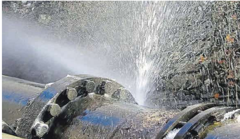
Trabajos de reparación de una fuga de agua en una tubería.
