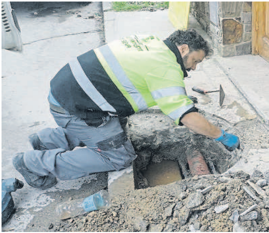
Reparación de una tubería con pérdidas de agua
